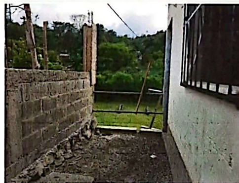
Levantamiento de paredes laterales
