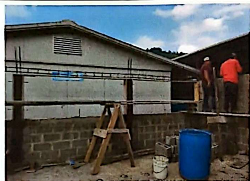
Avances en el levantamiento de paredes
