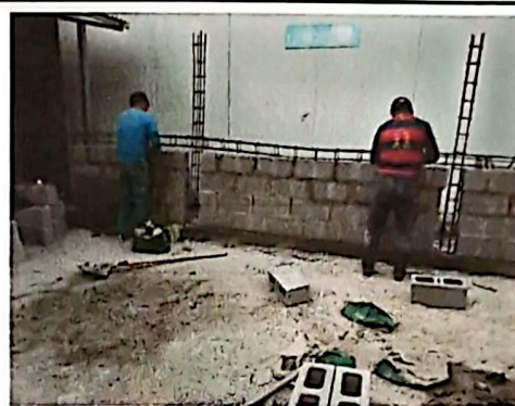
Levantamiento de paredes
